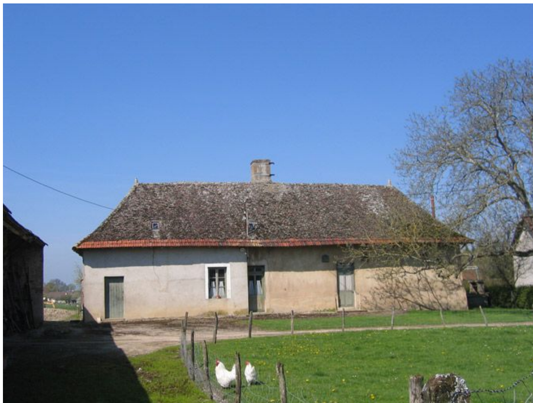
Vue d'ensemble de la façade antérieure.
