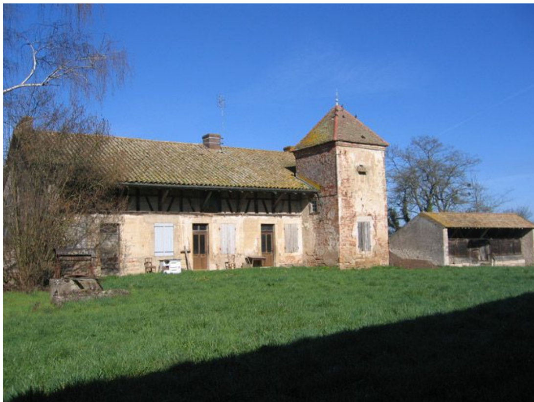
Vue d'ensemble de la façade de l'habitation.
