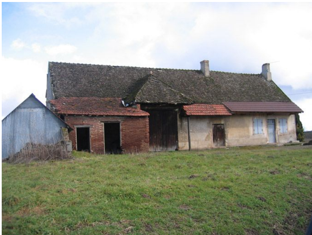
Vue d'ensemble de la façade.
