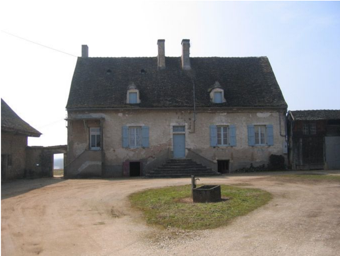
Vue d'ensemble de la façade de l'habitation.
