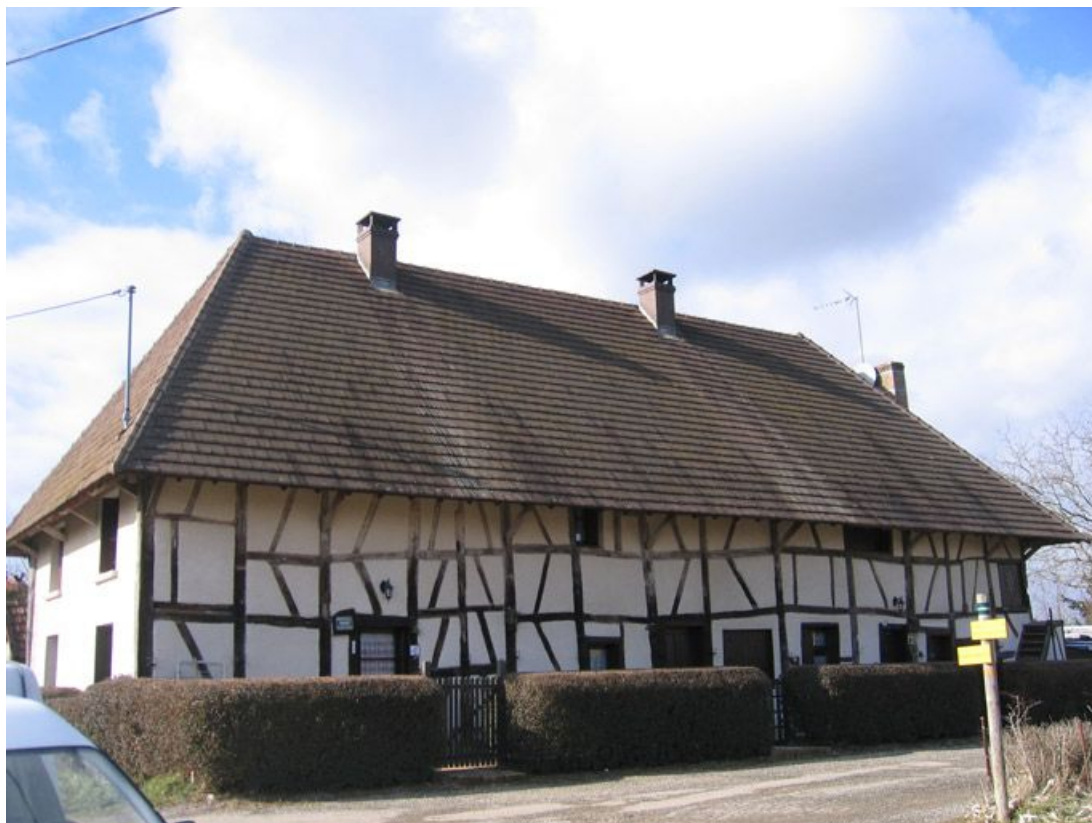
Vue d'ensemble de la façade.
