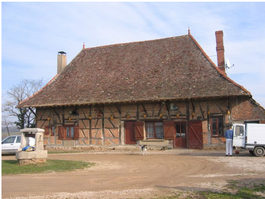
Vue d'ensemble de la façade de l'habitation.
