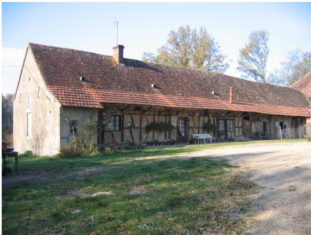
Vue d'ensemble de la façade.
