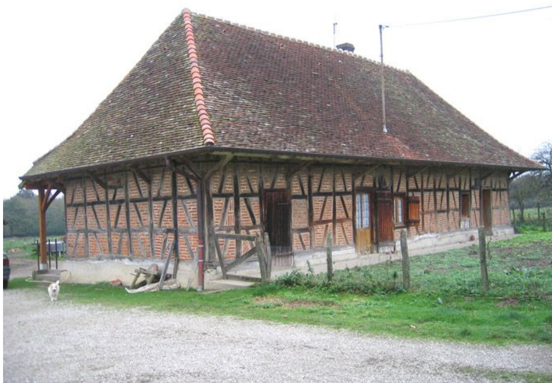
Vue d'ensemble de la façade.
