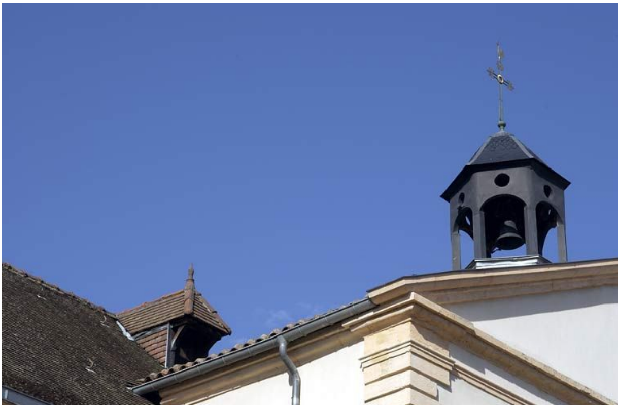
Détail du clocheton de la chapelle.
