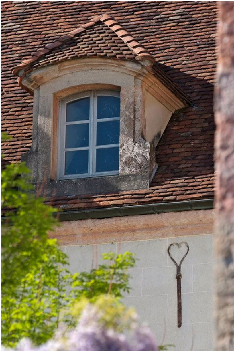
Détail de la toiture : lucarne.
