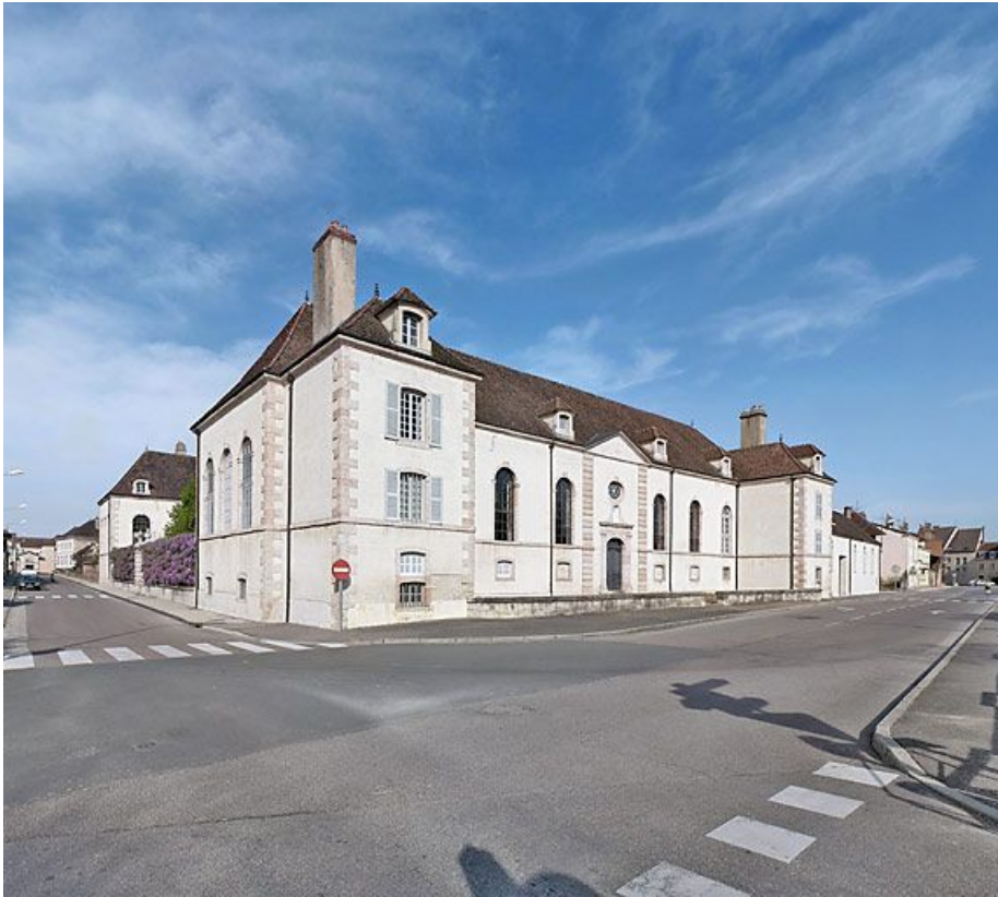
Façade sur la rue Edgar Guigot.
