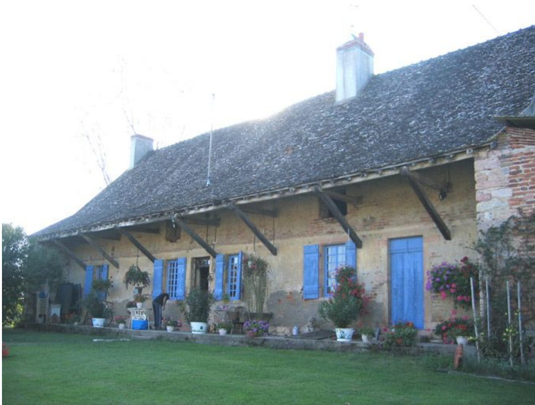
Vue d'ensemble de la façade.
