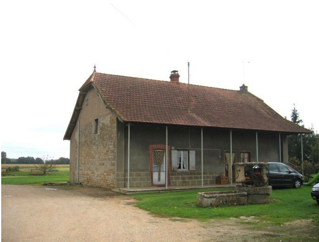
Vue d'ensemble de la façade de l'habitation.
