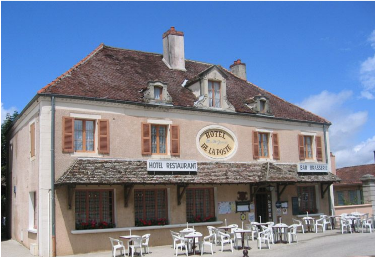
Vue d'ensemble de la façade.
