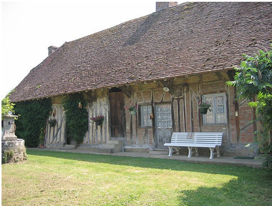
Vue d'ensemble de la façade.
