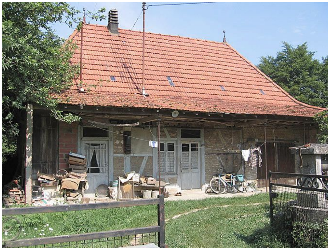
Vue d'ensemble de la façade.
