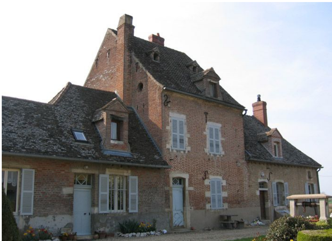
Vue d'ensemble de la façade.
