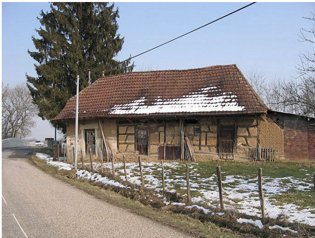
Vue d'ensemble de la façade.
