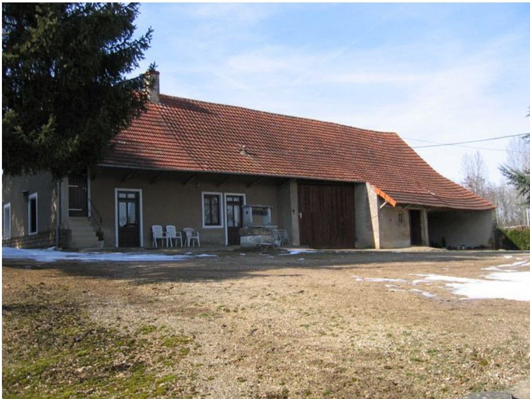
Vue d'ensemble de la façade.
