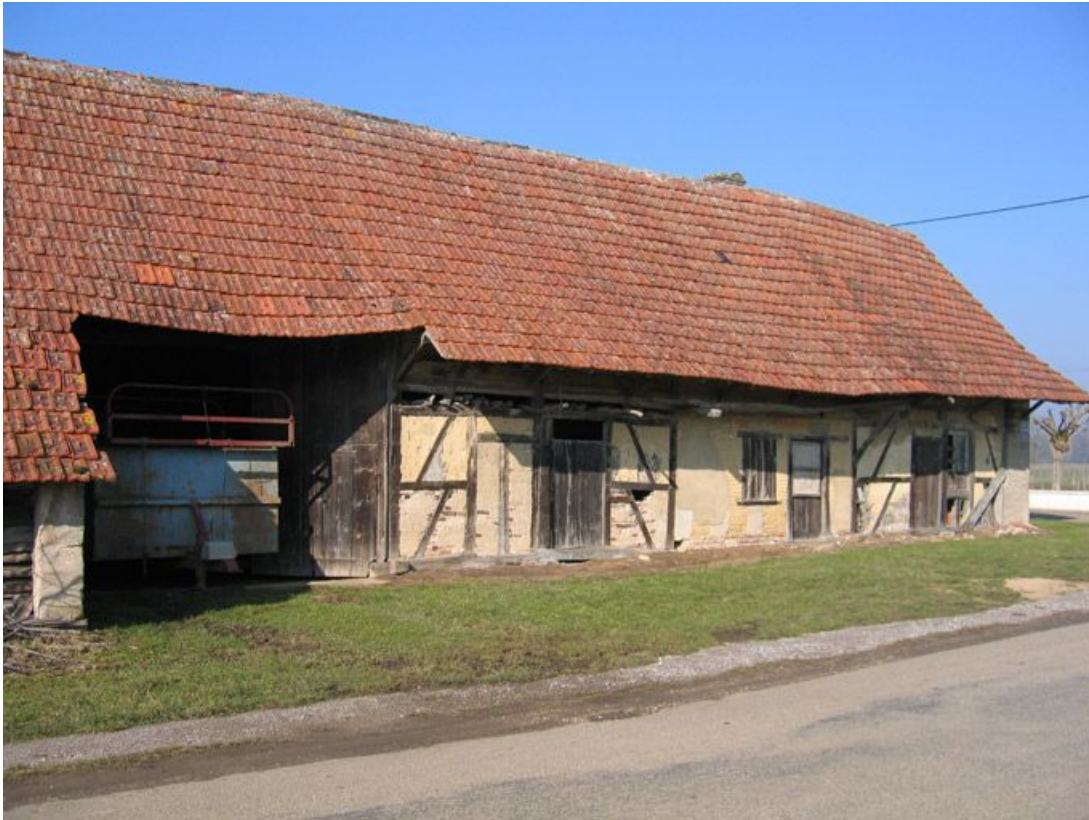
Vue d'ensemble de la façade.
