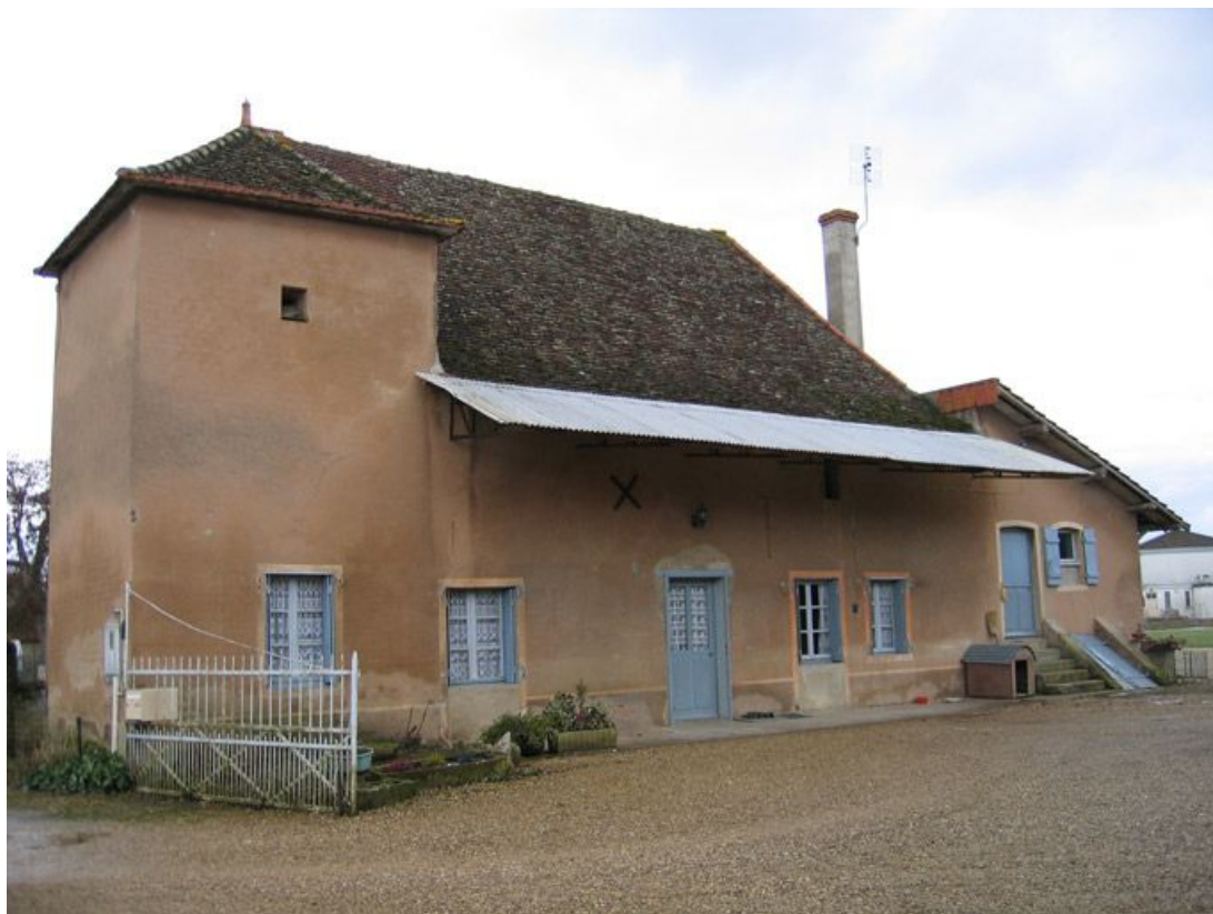
Vue d'ensemble de la façade.
