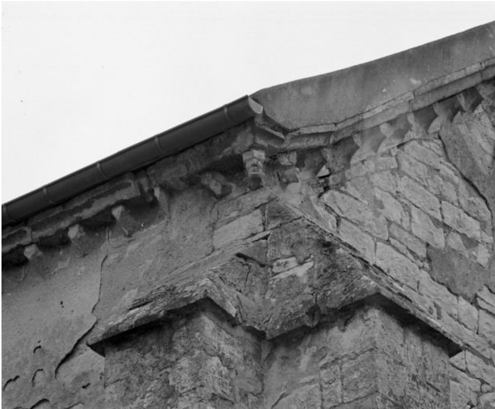
Façade : détail de l'angle gauche du pignon.
