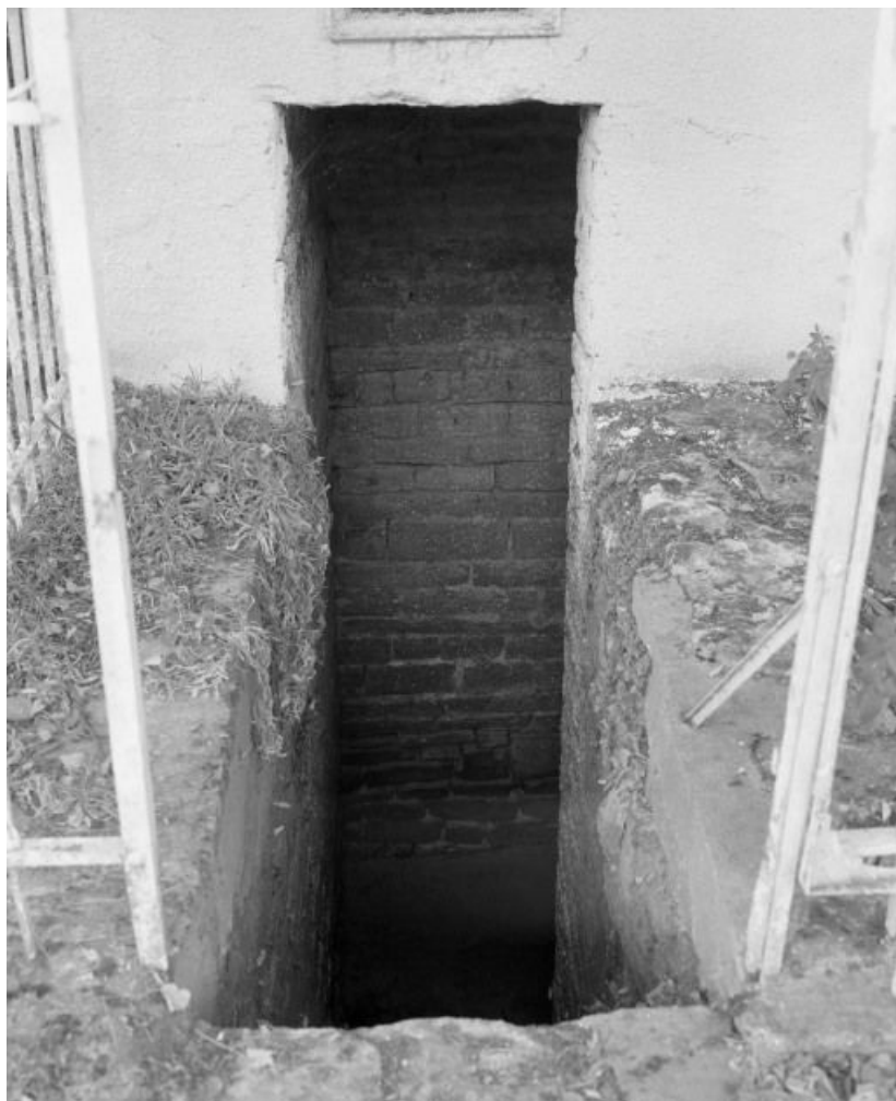
Escalier rentrant d'accès à la source.
