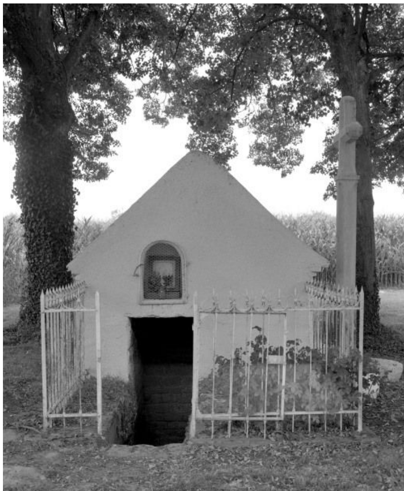
Façade de l'oratoire.
