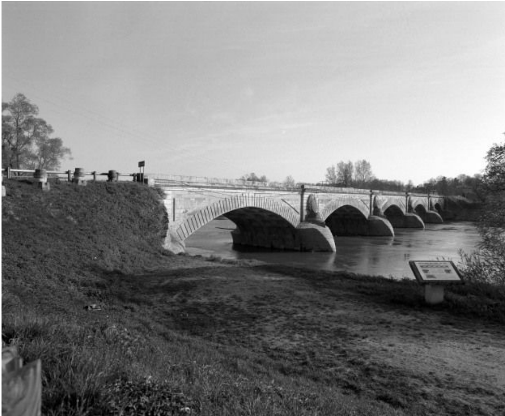
Vue d'ensemble de trois-quarts gauche, en aval.
