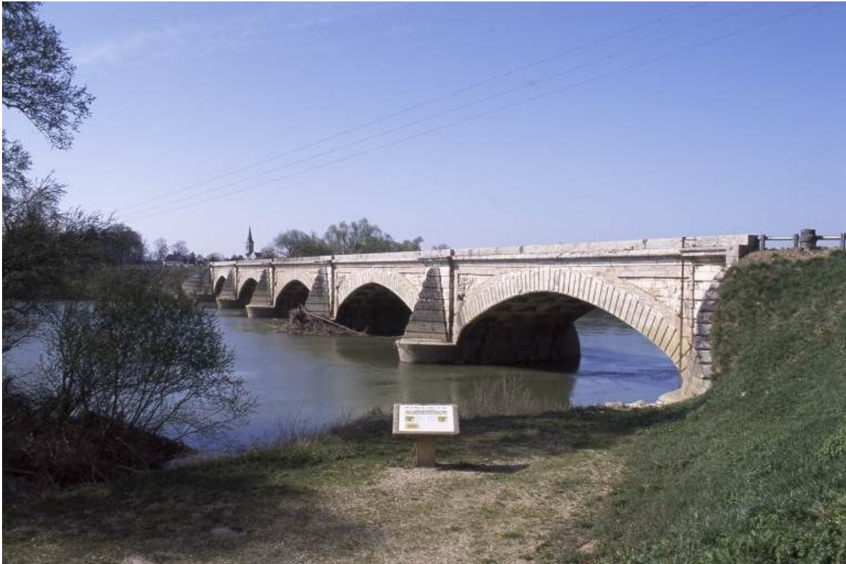
Vue d'ensemble en amont.
