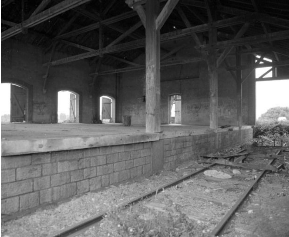
Gare de marchandises, intérieur.
