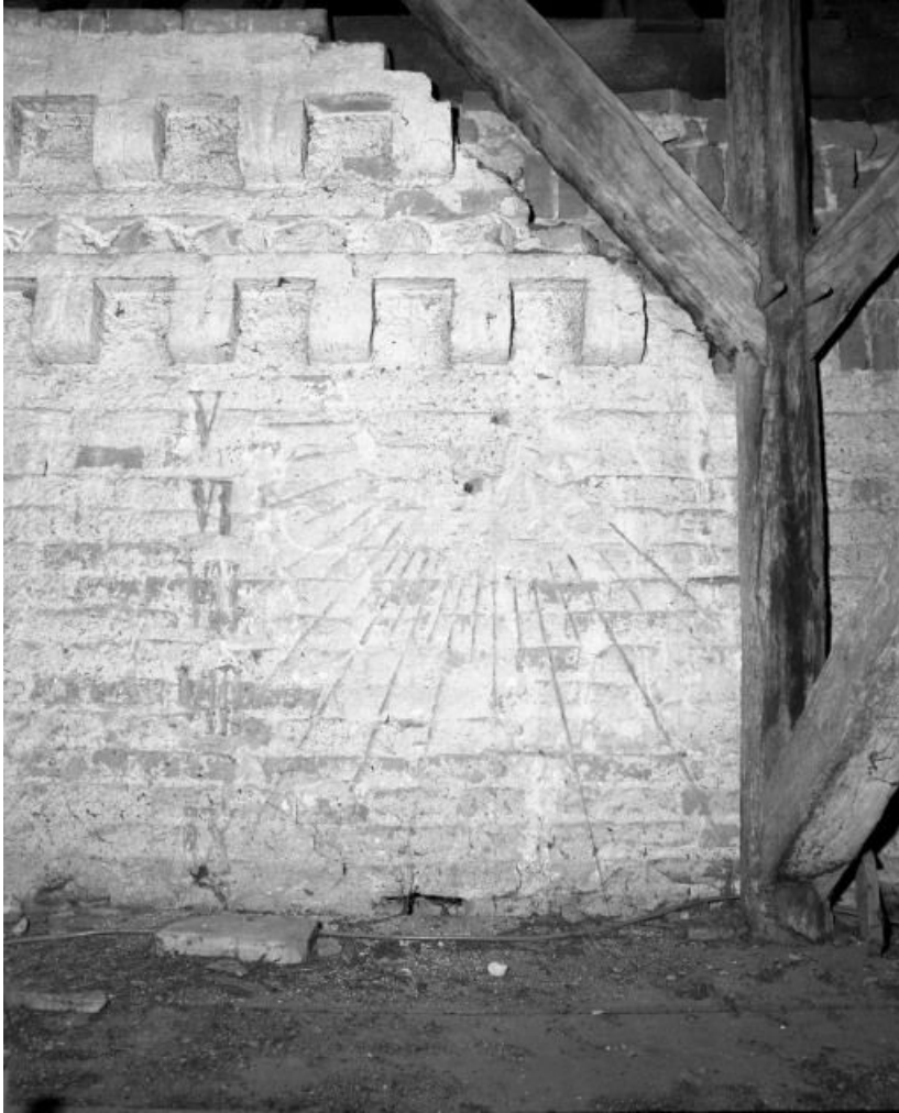
Comble de la chapelle droite : cadran solaire.
