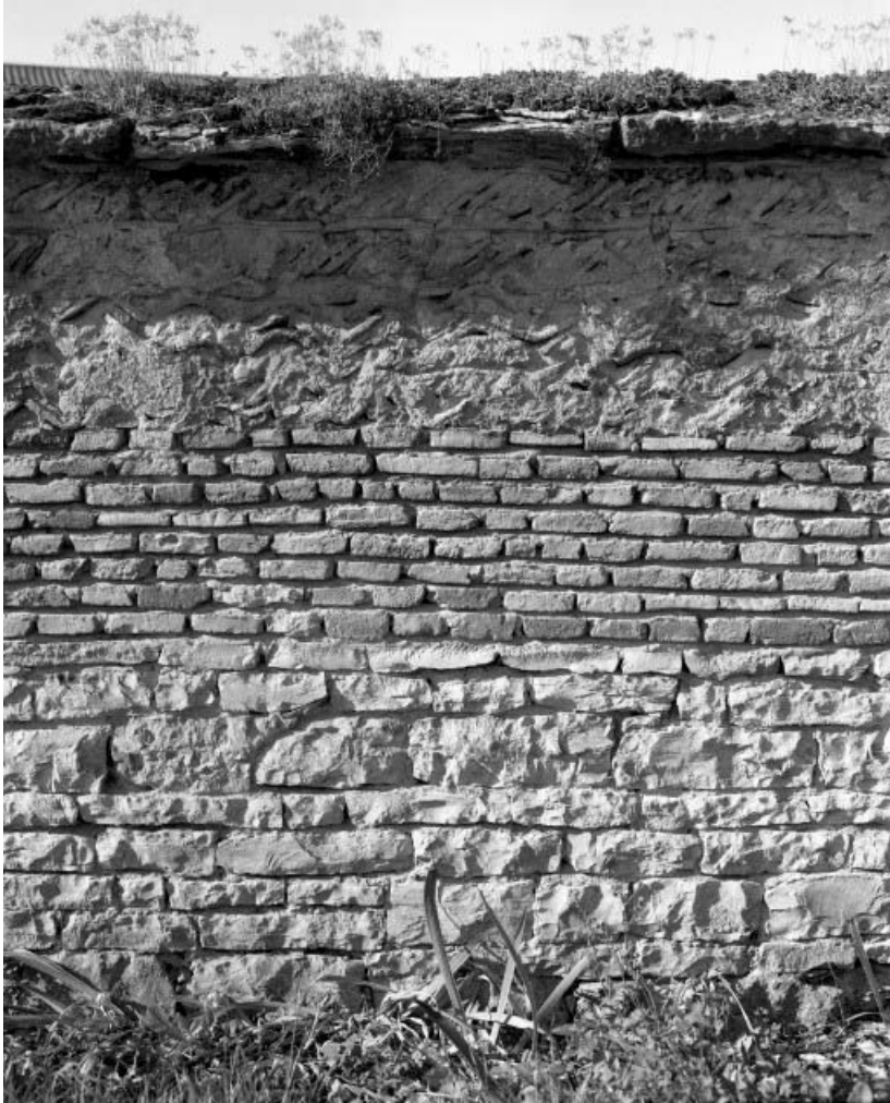
Détail d'un mur de clôture.
