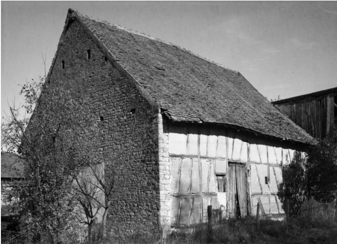
Bâtiment des dépendances.
