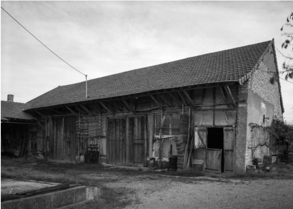
Bâtiment des dépendances.
