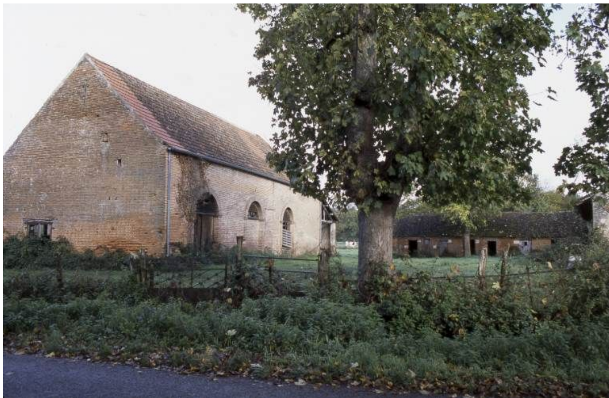
Grand bâtiment de dépendances.
