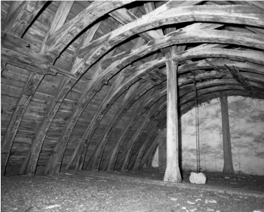
Comble du chœur, partie gauche.
