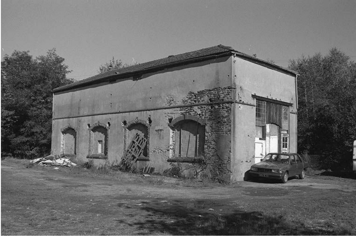
Salle des machines, vue du sud-ouest.
