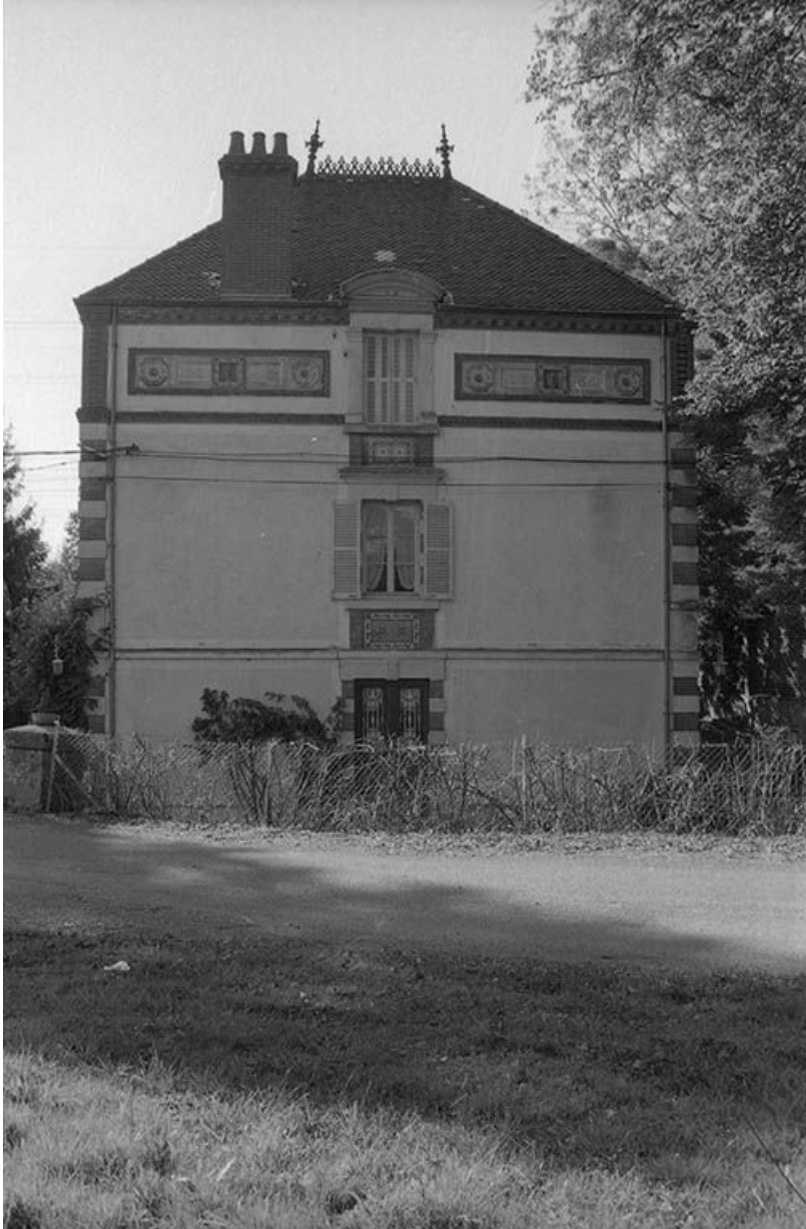
Façade est du logement patronal.
