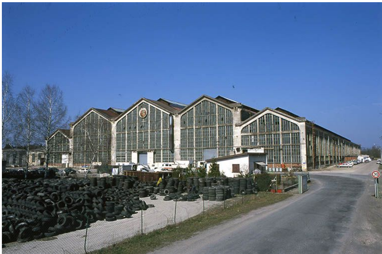
Elévation sud-ouest de la grande halle.
