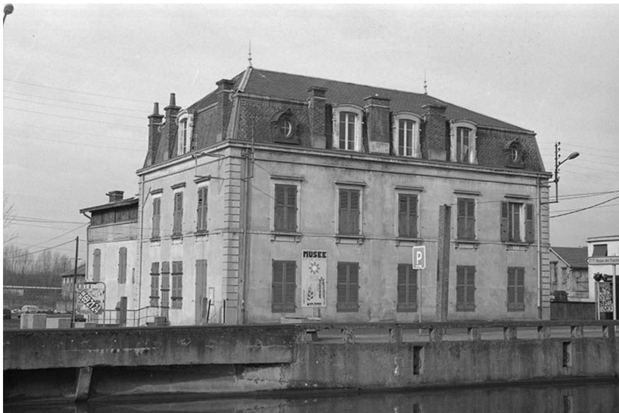
Logement d'ingénieur construit en 1847-50 : vue d'ensemble.
