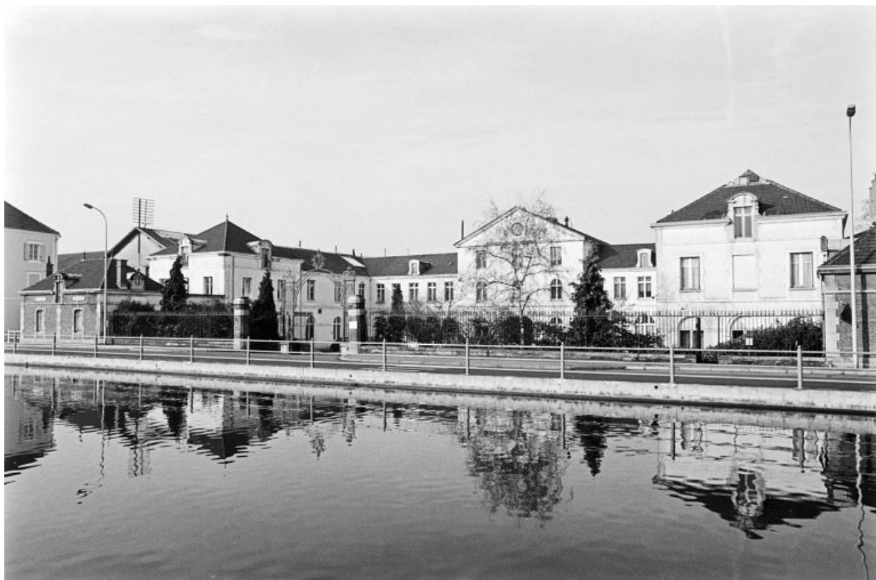
Façade antérieure des ateliers et bureaux centraux.
