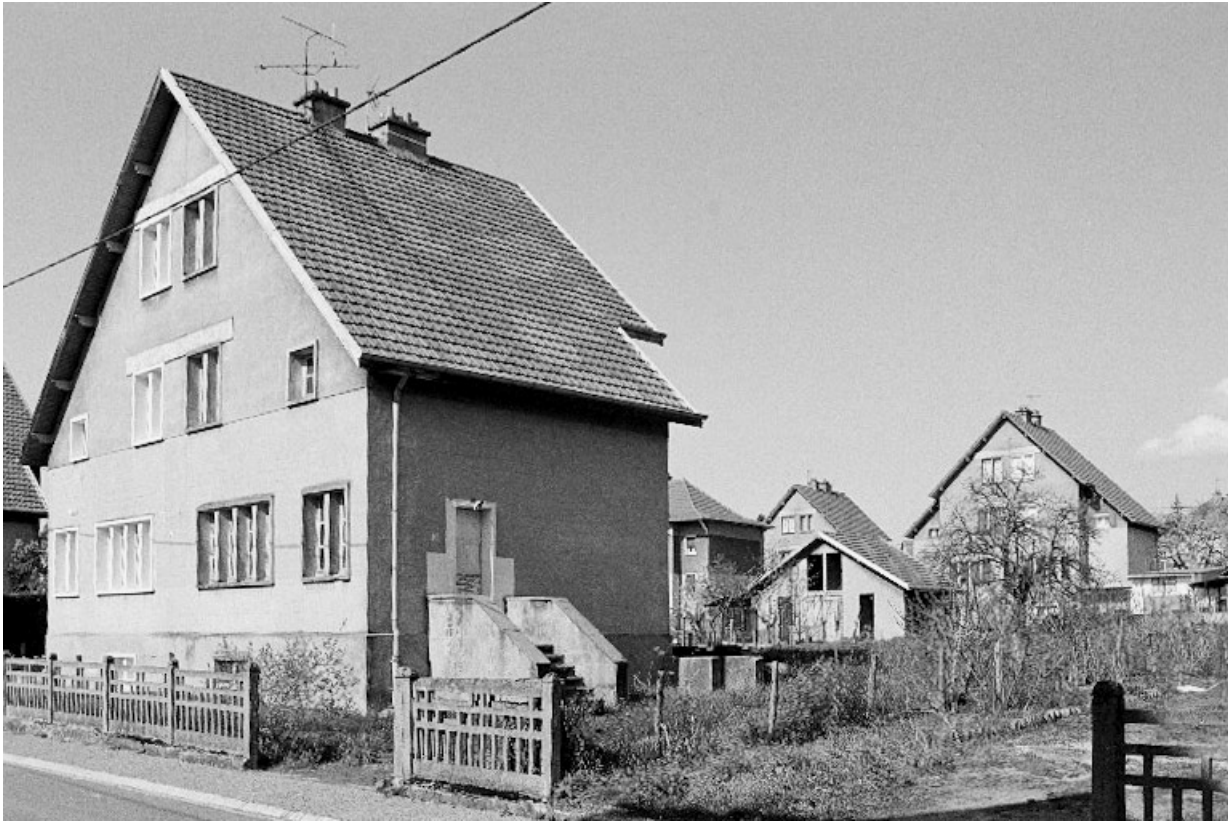
Bâtiment à 2 logements " type 16 " à meneaux, 1946-1948.
