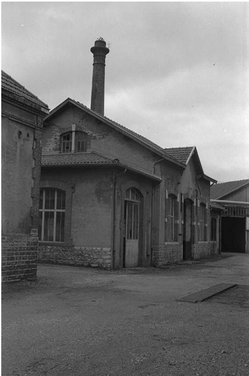
Façade antérieure de l'atelier de montage.
