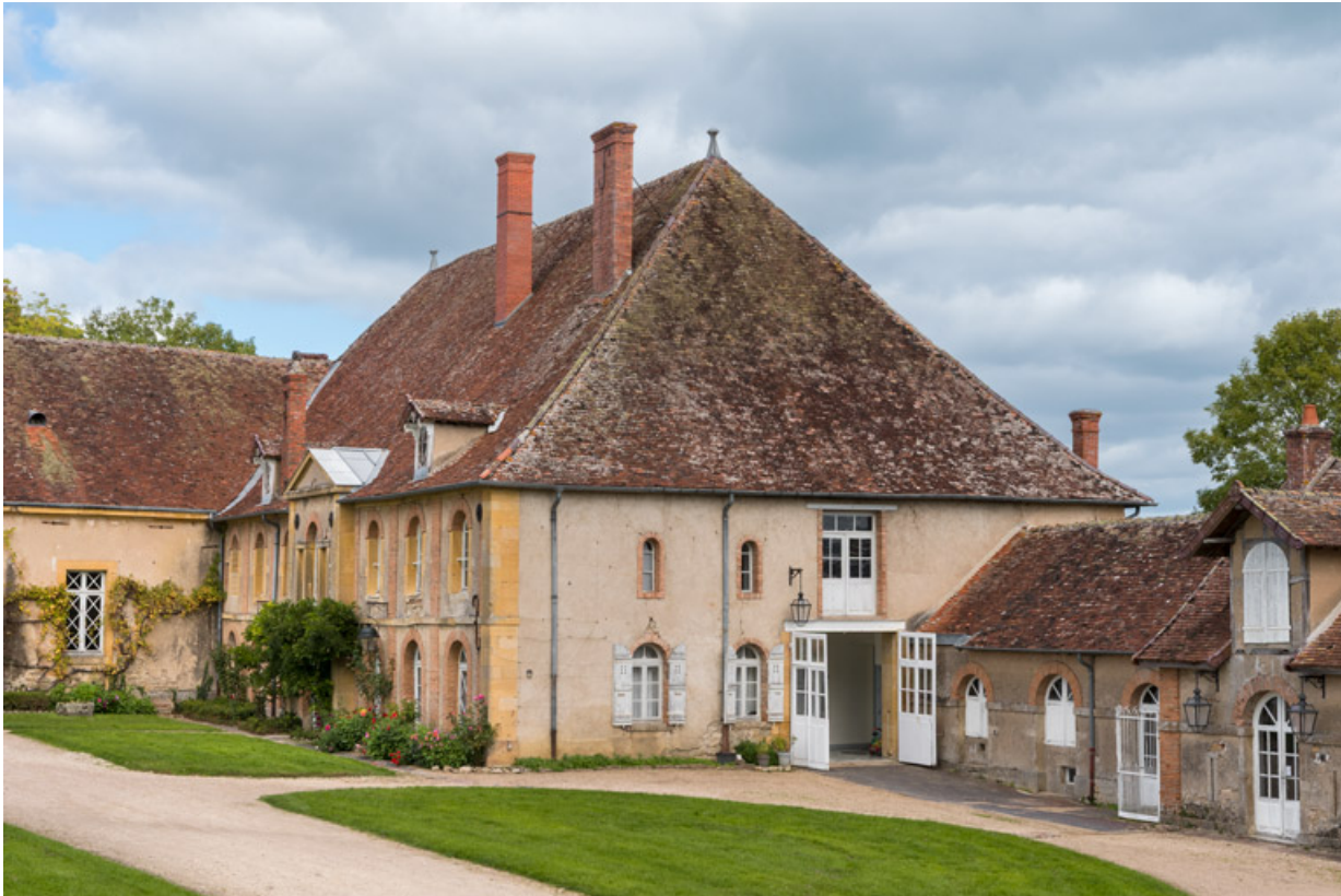
Façades antérieure et latérale droite.
