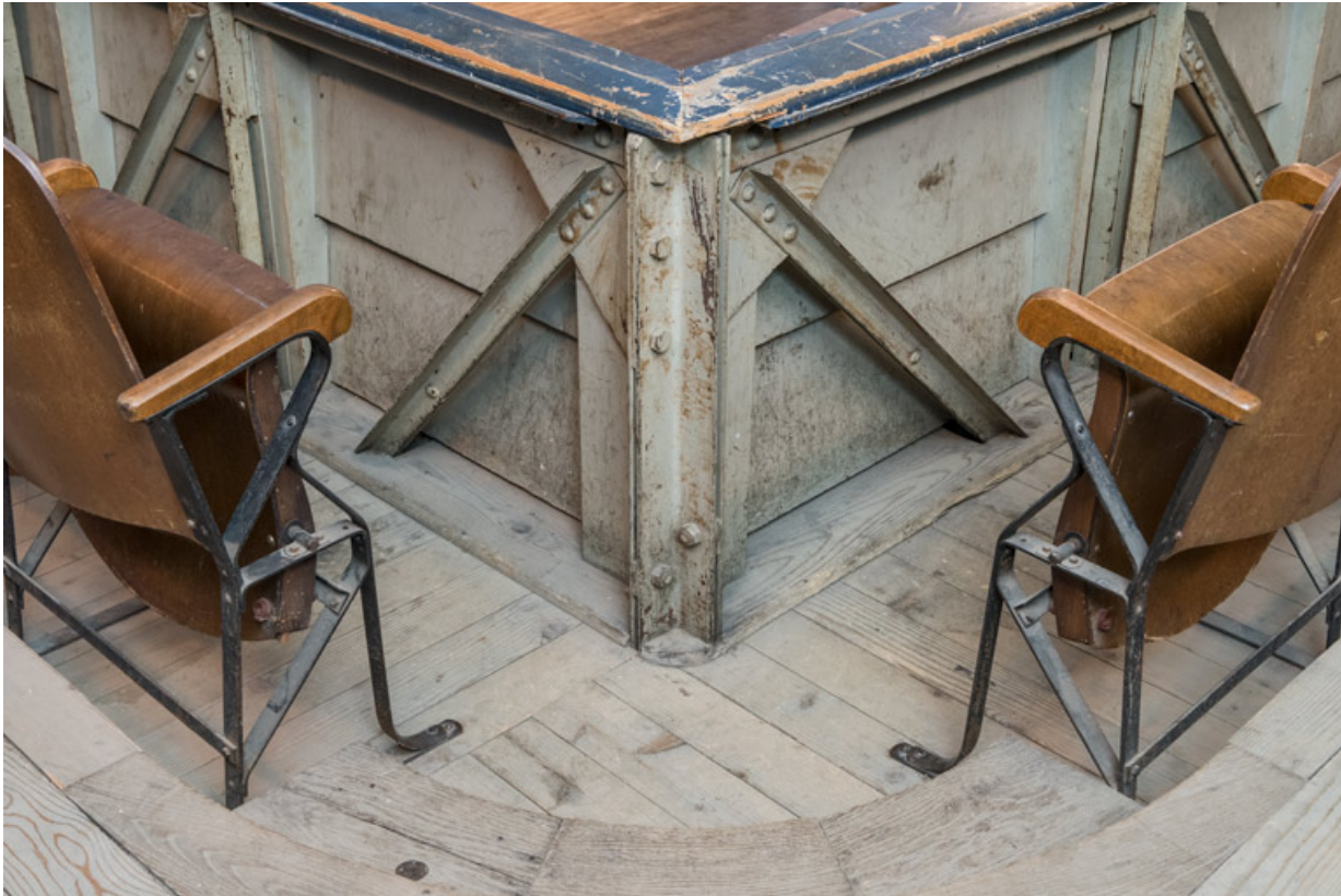
Balcon : structure métallique du garde-corps.
