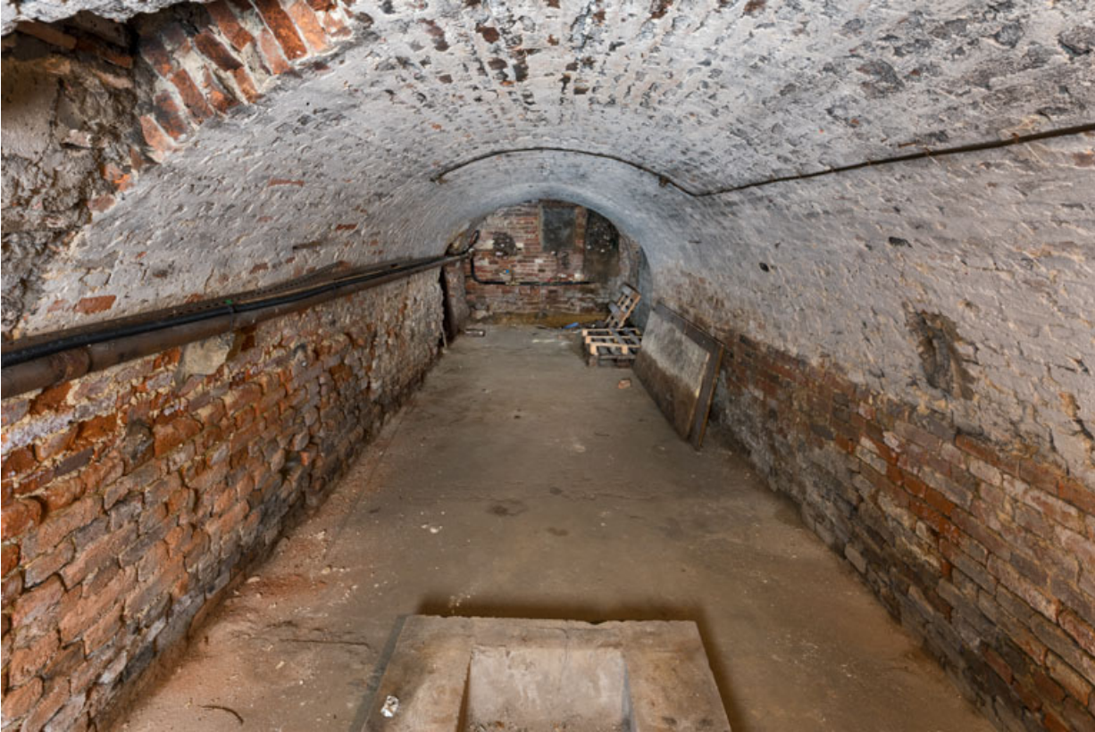
Cave voûtée au sous-sol.
