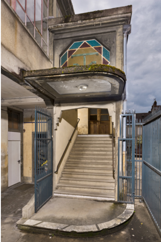
Cage de l'escalier principal.
