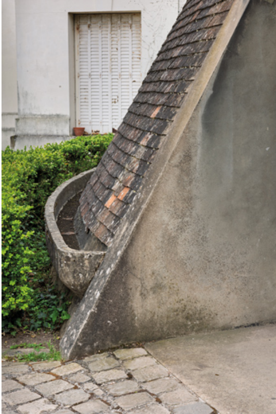
Jardinière à la base de la toiture.
