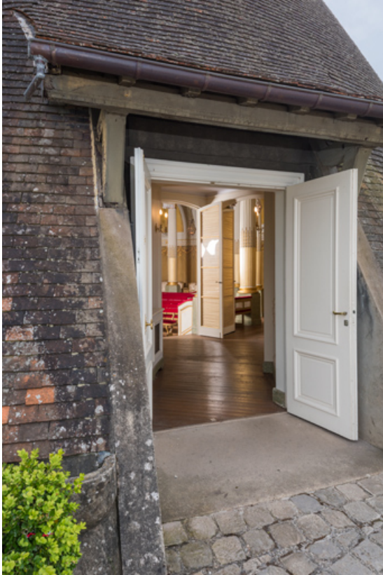
Entrée, côté nord-est.
