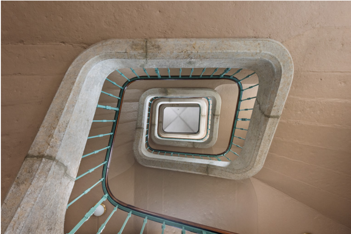
Escalier côté cour, vu en contre-plongée.
