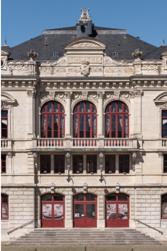
Façade antérieure : travée centrale.
