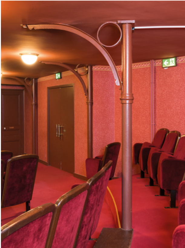
Poteaux métalliques supportant le 1er balcon.
