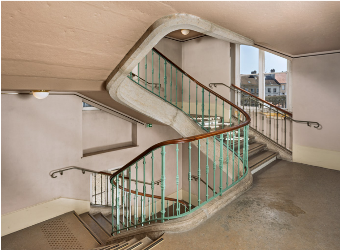
Escalier côté cour : un palier.
