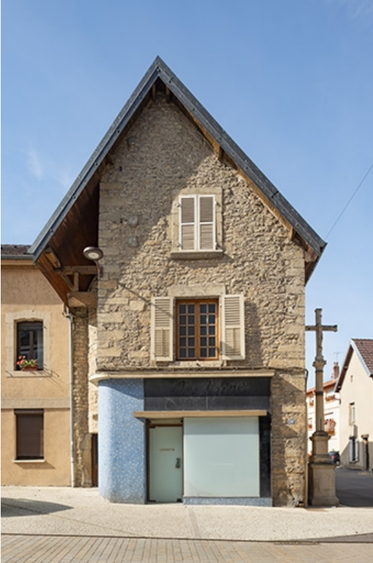
Le pignon depuis la rue Gambetta.
