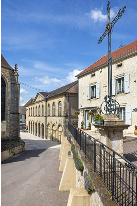
Vue éloignée depuis le sud.
