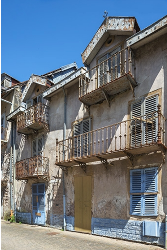
Balcons de l'ancienne maison.
