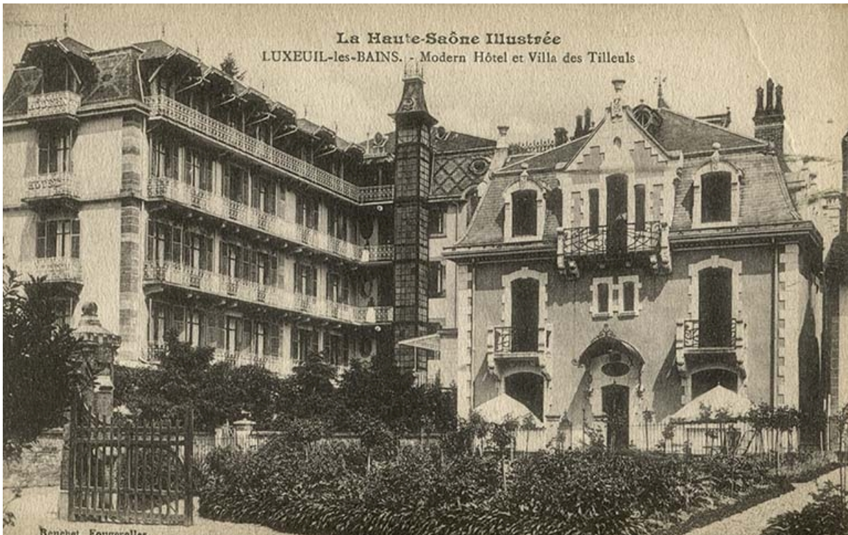
Vue ancienne (deuxième quart du 20e siècle).
