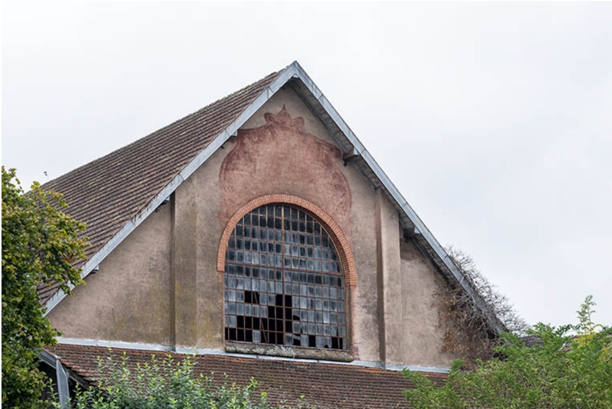
Mur-pignon sud, baie du pignon.
