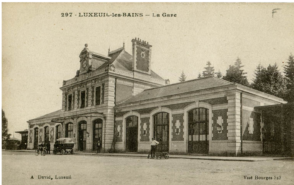
Façade, vue de trois quarts (vue ancienne).
