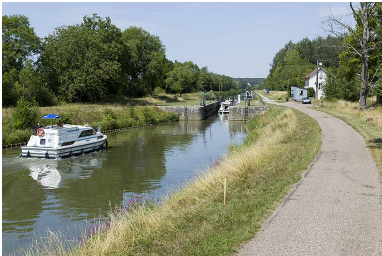
Vue amont du site d'écluse.
