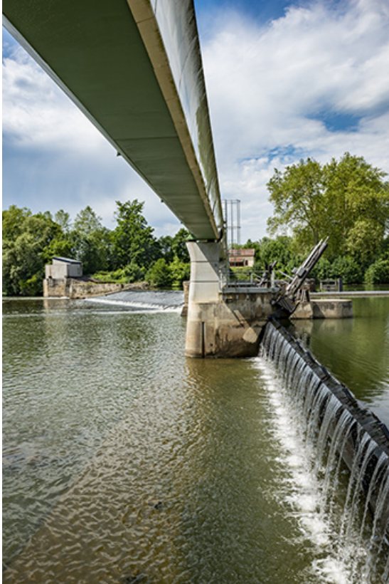
Barrage mobile d'Apremont.
