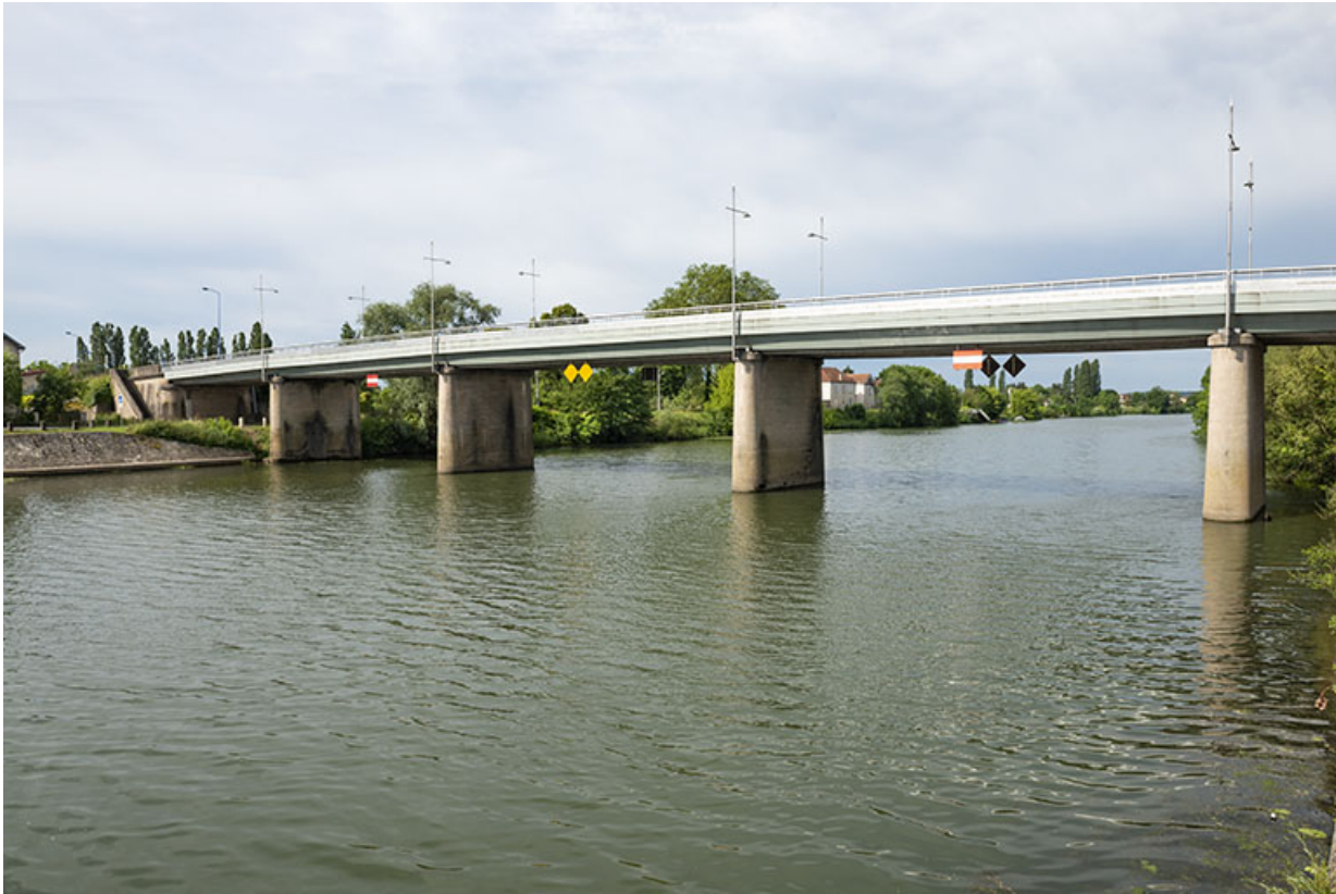
Le pont reconstruit après guerre.
