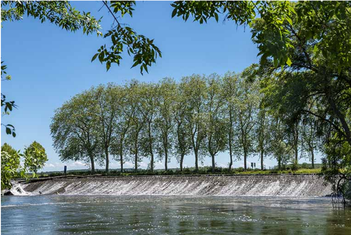
Déversoir en amont du barrage.
