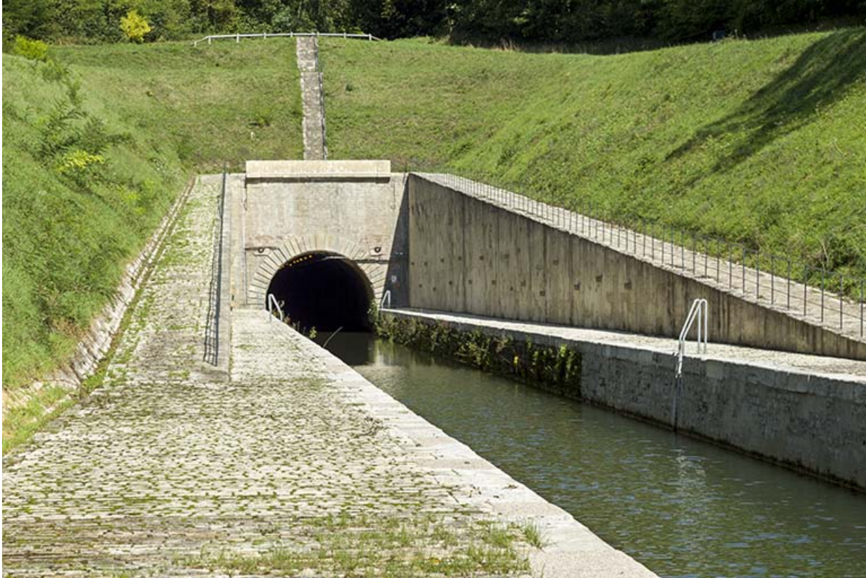
Entrée aval depuis le chemin de halage.
