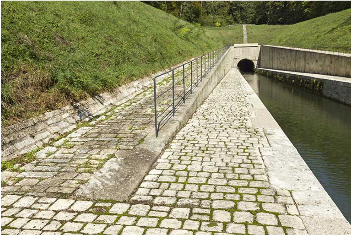
Pavage du chemin de halage.
