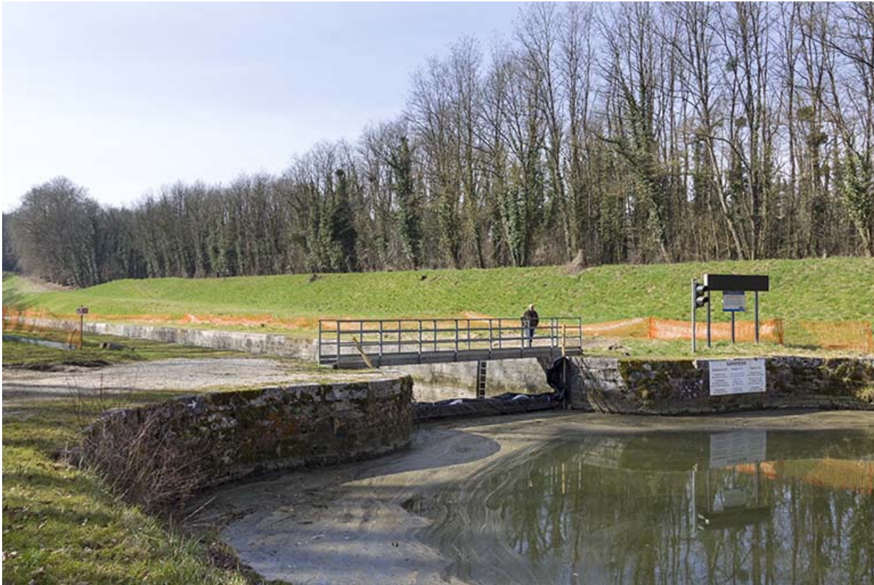
Entrée amont menant au tunnel.
