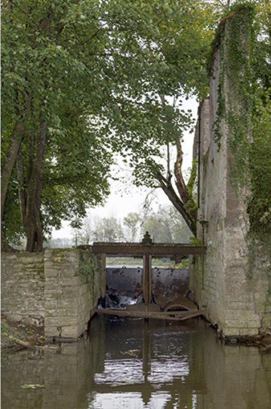
L'ancien canal de dérivation du moulin.
