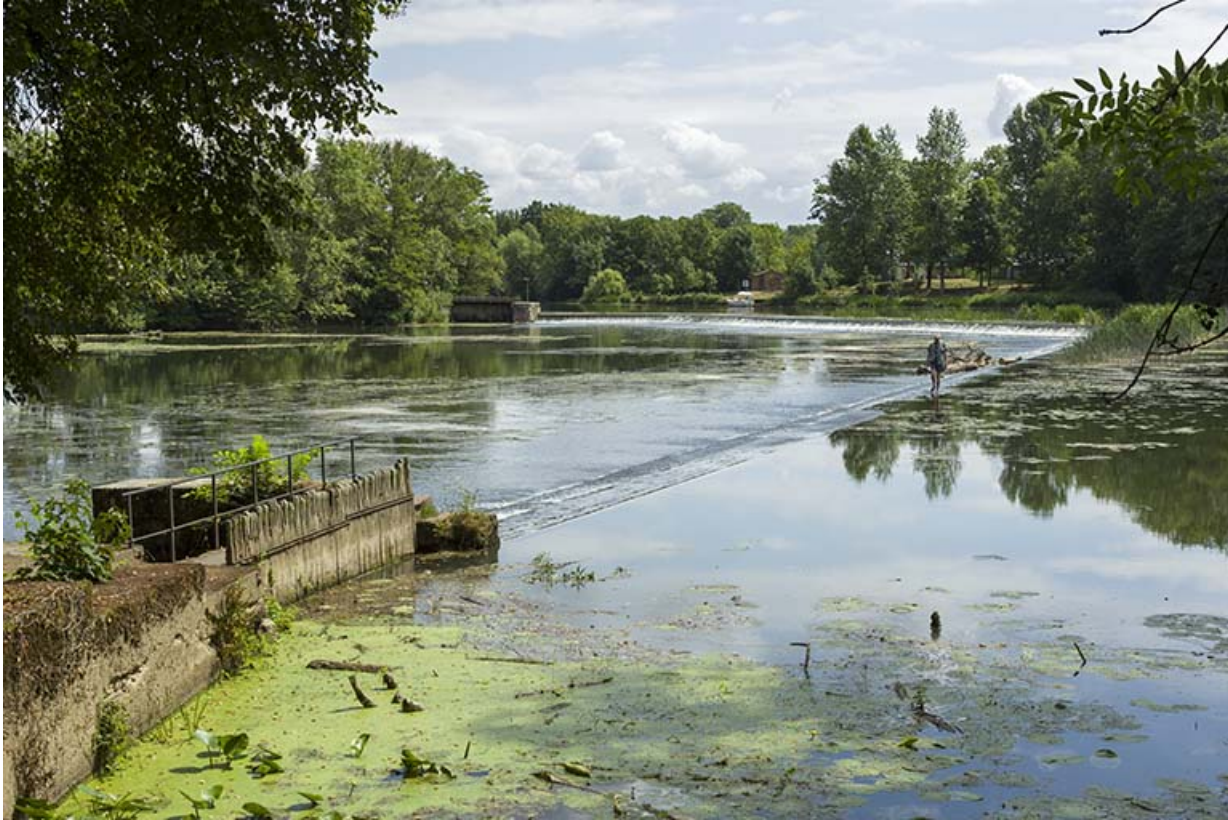
Ancien barrage usinier et la Saône.
