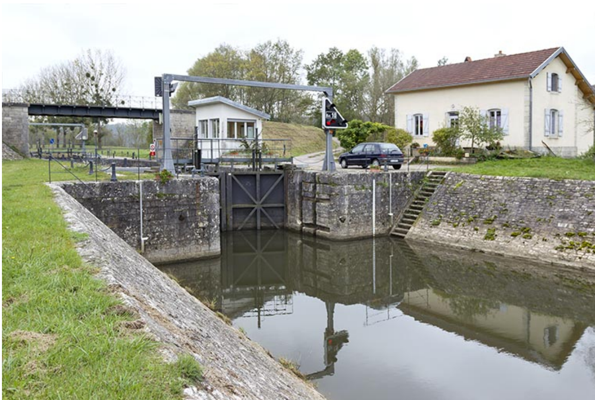
Vue aval de l'entrée du sas.
