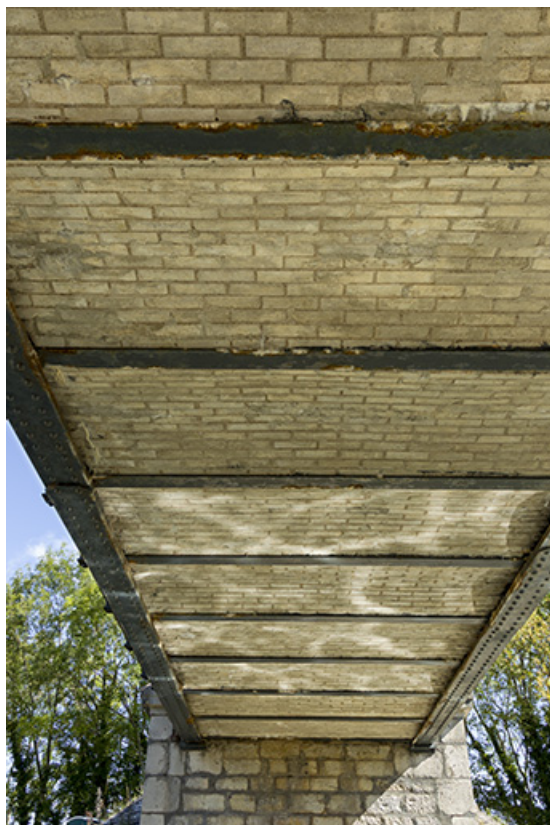
La voûte du pont.
